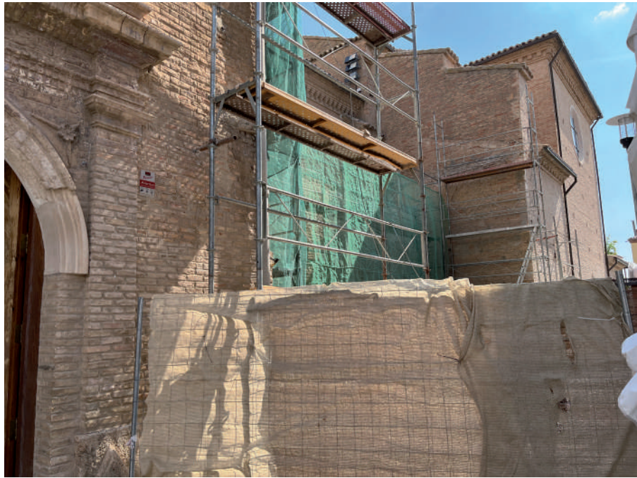
Las obras de adecentamiento de la fachada de la iglesia ya han comenzado.
