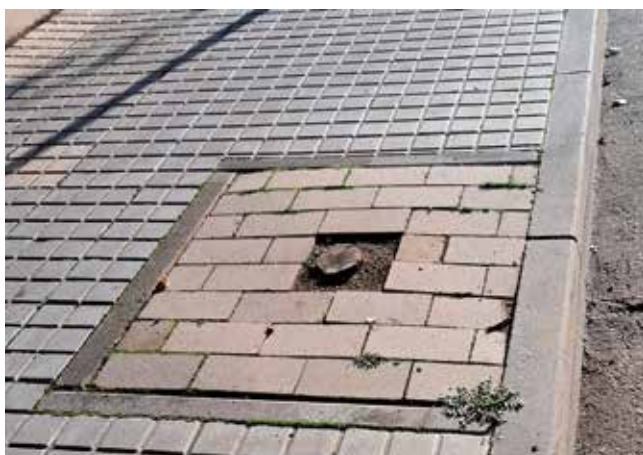
Fotografía: Pavimentar elimina huecos y desniveles y recupera espacio para el peatón
