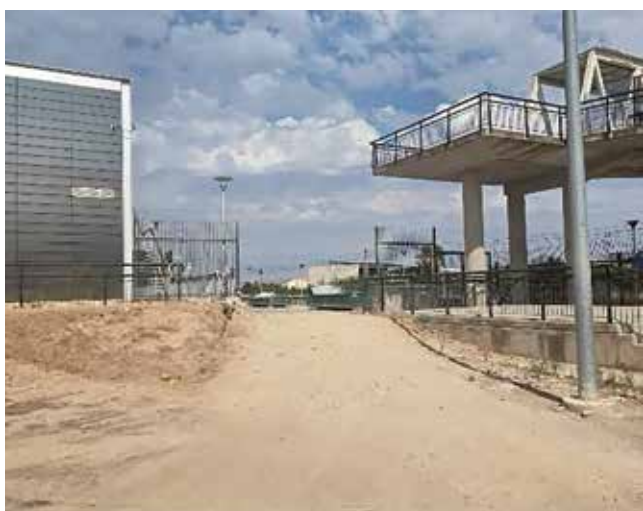
Fotografía: La actuación mejorará el acceso y la seguridad de las instalaciones.
