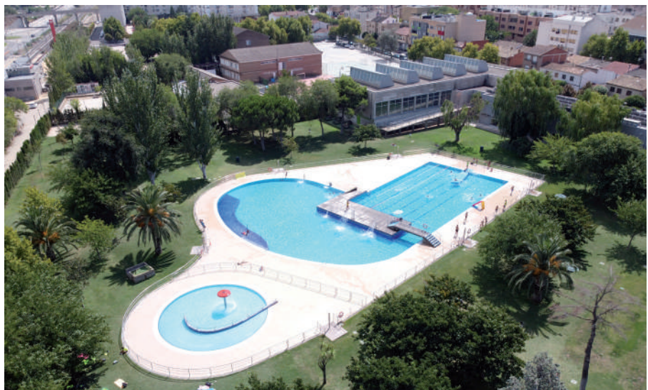
Fotografía aérea de la piscina municipal de Utebo en la actualidad.
