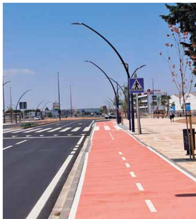
Fotografía: Las glorietas y pasos de cebra facilitan la entrada y salida de la localidad a vehículos y peatones.
