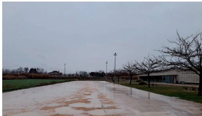
Fotografía: Los 1.220 metros cuadrados del parking pasarán a estar hormigonados.
