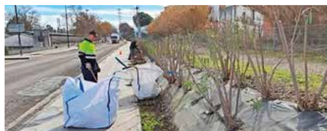
Fotografía: Trabajos de limpieza vegetal y desbroce.
