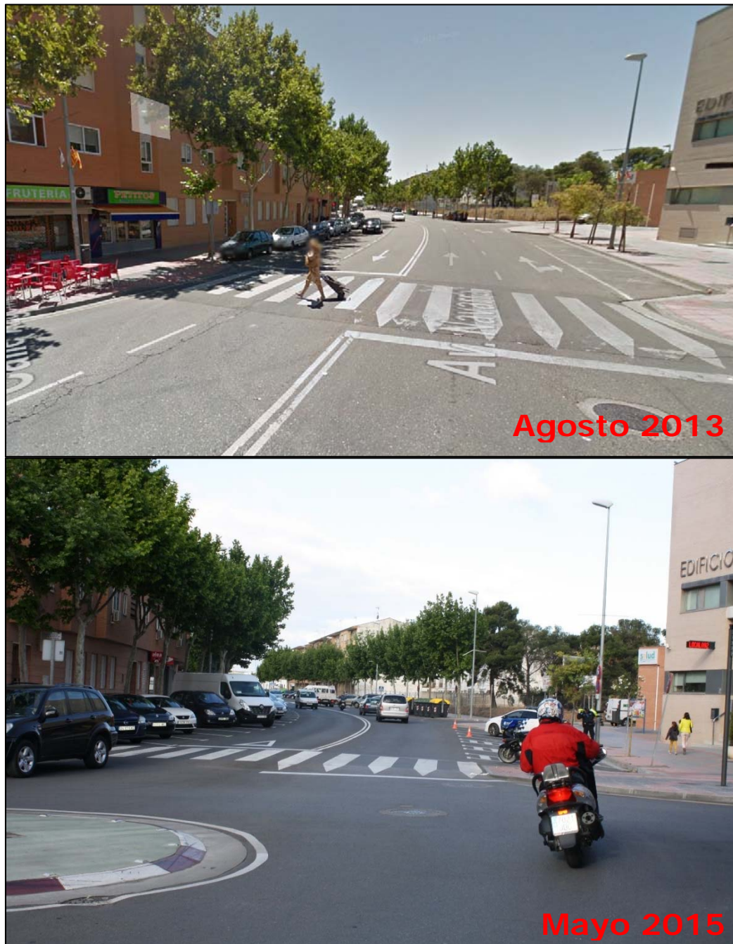
Figura 2: Imágenes del antes y el después de las obras en la Avenida de Navarra.
